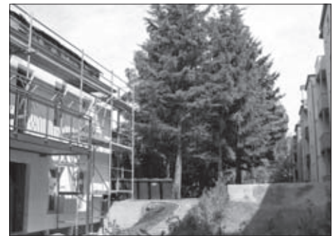
Alter Baumbestand im Hof der Heinickestraße 3 und 5. Links das ehemalige Wirtschaftsgebäude des Herrn Richard Rudolph, Heinickestraße 1.
