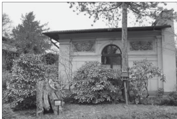
Bauten von Otto Brückwald (Frühjahr 2012)
