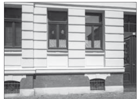
Die Salzmannstraße 13 am 28. August 2015; zu erkennen der zugesetzte Eingang (fehlendes Kellerfenster) zum ehemaligen Bäckerladen – heute Wohnraum
