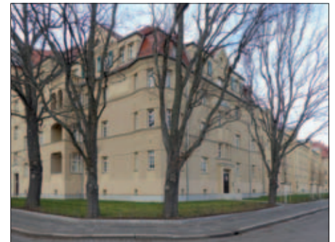
Von der VLW sanierter Bestand in der Wustmannstraße
