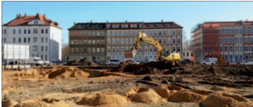
Die Baustelle am 20. März 2019
