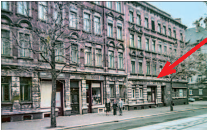
Die Wittenberger Straße 28 und 26 (von links, früherer Lebensmittel-laden: Pfeil), 1975
