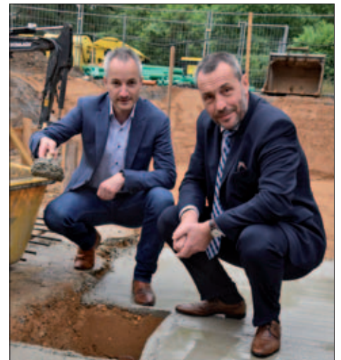
Grundsteinlegung durch den Vorstand der VLW: Sven Moritz (links) und Wolf-Rüdiger Kliebes (rechts) Bildquelle: VLW eG
