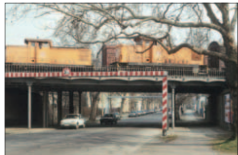
Ursprünglich sollte die Fahrbahn unter der Brücke nicht abgesenkt werden!
