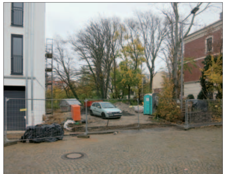
Das Grundstück Petzscher Straße 3, am 17. November 2022. Links der Neubau Nr. 1, rechts das Doppelhaus Nr. 5 und 6.
